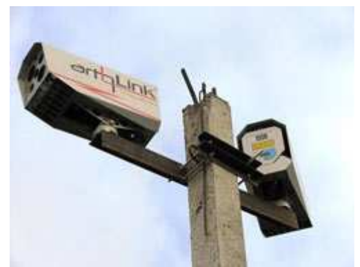
Беспроводный оптический канал связи M1 ARTOLINK (ООО МОСТКОМ) в Сочи - дистанции связи от 1.5 км до 2.5 км
