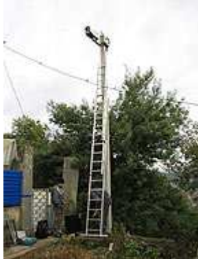
Беспроводный оптический канал связи M1 ARTOLINK (ООО МОСТКОМ) в Сочи - дистанции связи от 1.5 км до 2.5 км
